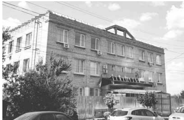
Такий вигляд має будівля козятинської міської сімейної медицини зараз. Вже завершили встановлення дерев'яних конструкцій під майбутній новий дах
