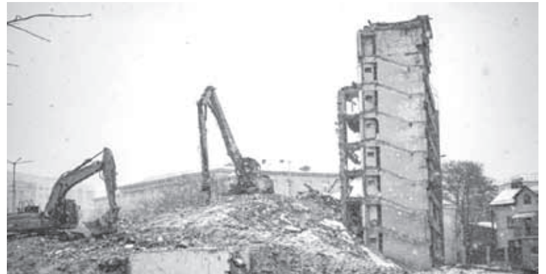
«Реконструкція» готелю «Південний Буг». Нині тут триває будівництво нового житлового комплексу
