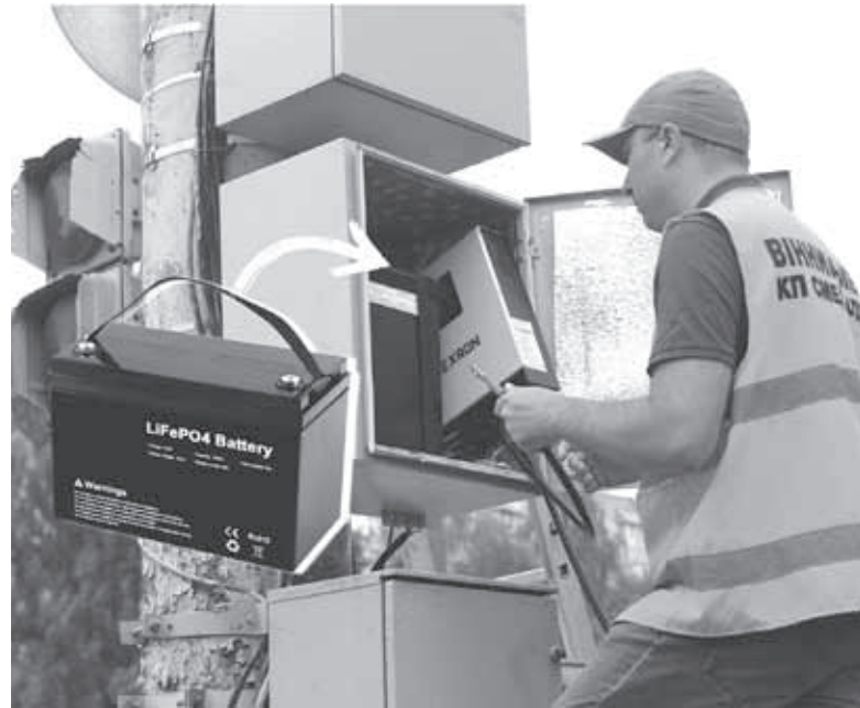
Резервне живлення для світлофорів діє на 25 перехрестях. Там замінили старі батареї на нові, літій-залізо-фосфатні акумулятори
