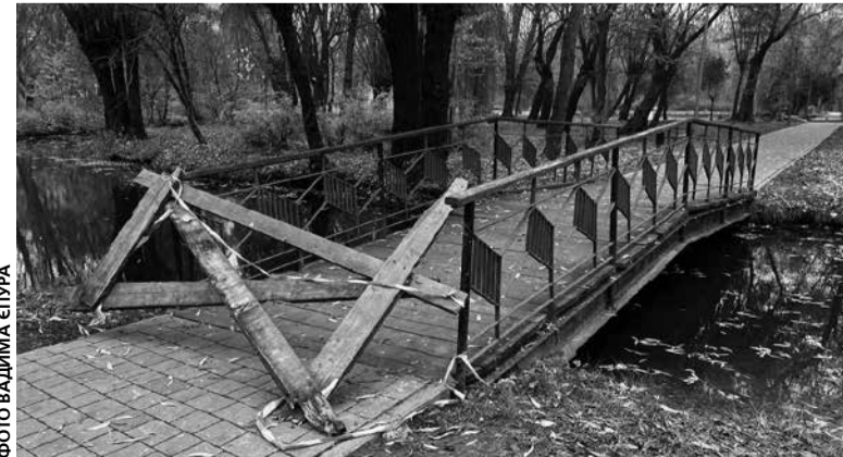
Прохід до деяких мостів перекрили через ремонт. На ремонт витратили майже 200 тис. гривень
