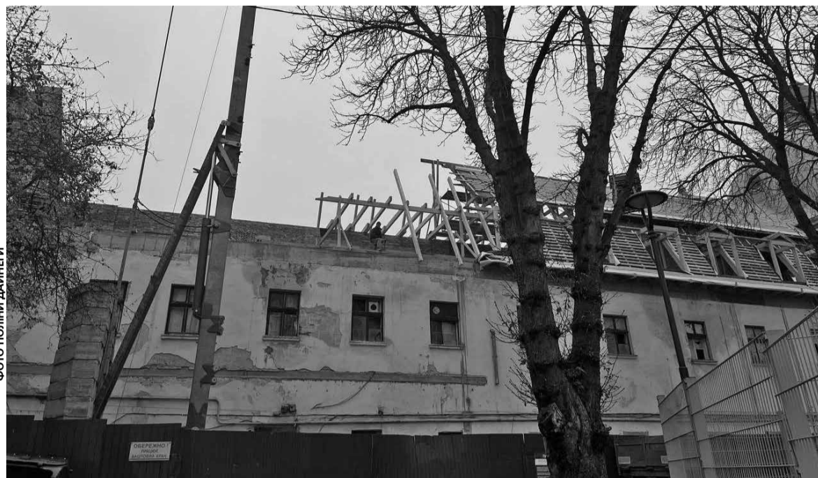
На місці працює великогабаритна техніка, що піднімає бетонні блоки та дерев'яні дощечки на горище
