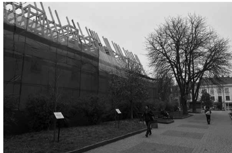
Навколо забудови є спецсітка та металеве риштування
