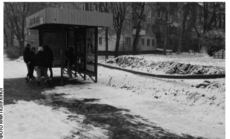
На вулиці Слівенській почали роботи з будівництва зупинки та торгових приміщень. Там вже зрубали дерева і кущі
