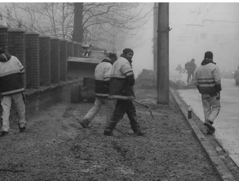
Ремонтують тротуари на «Дружбі». Через це пішоходам доводиться обходити місця робіт
