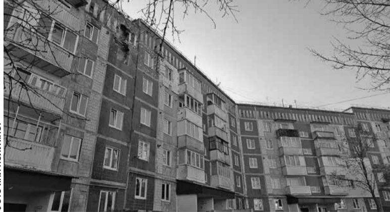
Роблять ремонти після підтоплень і відновлюють засклені балкони жителі будинку, що постраждав від дрона
