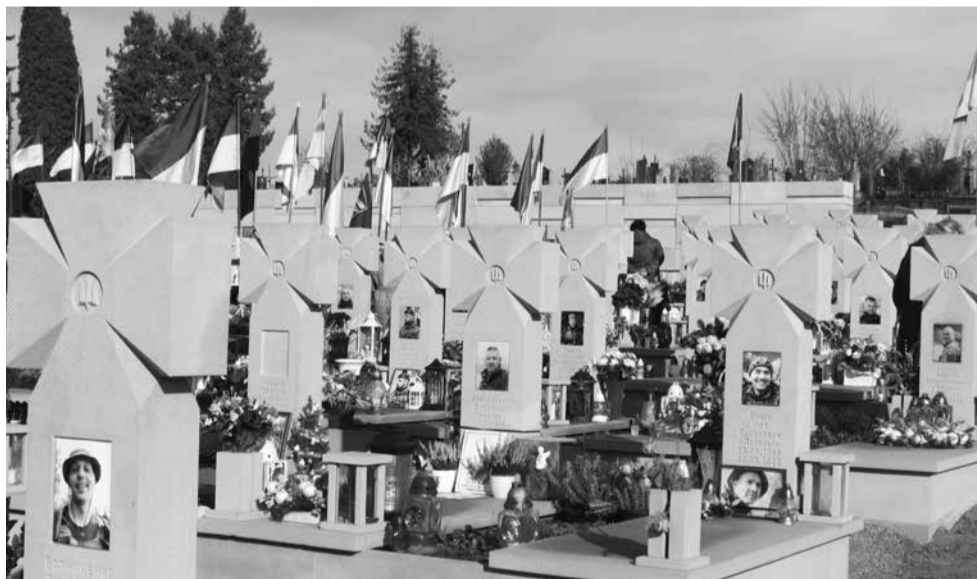
Триває будівництво Пантеону Героїв на Микулинецькому кладовищі. У вересні 2024 року там почали заливати фундамент для нової стели
