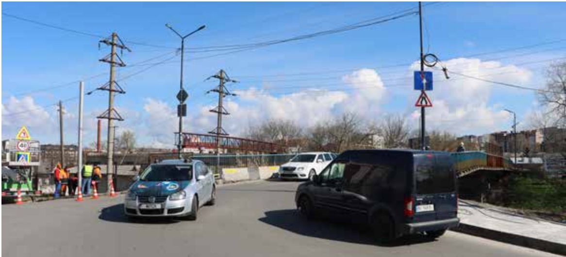
Робітники встановили опори та троси для обмеження руху на в'їзді до мосту
