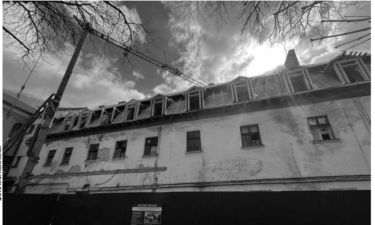
На місці працює великогабаритна будівельна техніка
