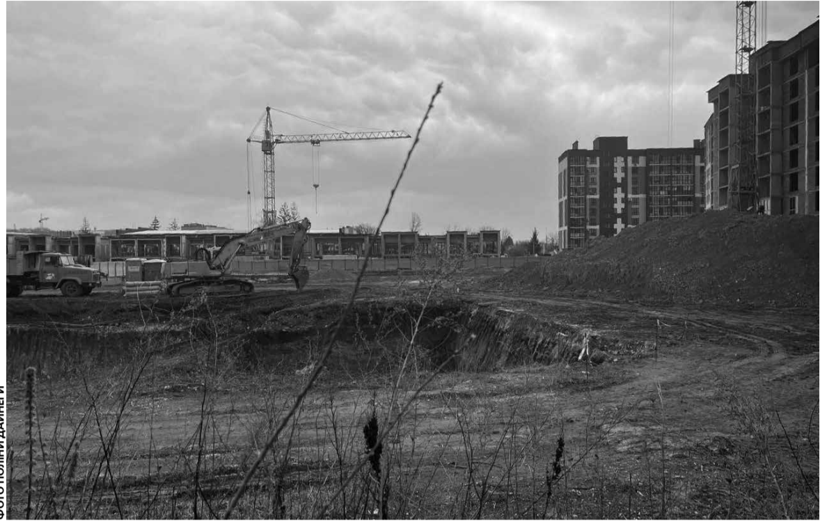
Будівельники вже очистили територію, вирили котлован
