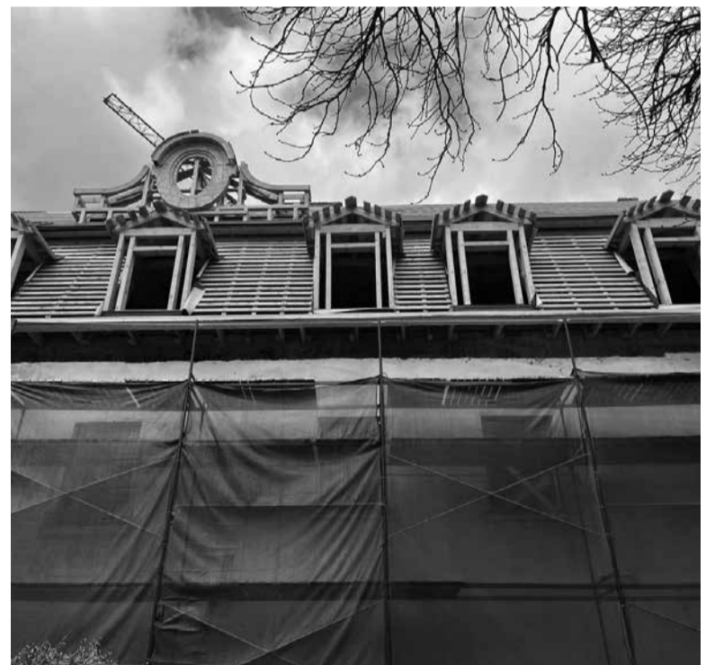
У приміщенні ще не замінювали вікна, не ремонтували фасад, а у мансарді додали десятки нових вікон
