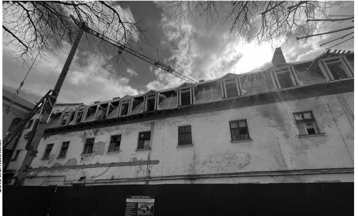
На місці працює великогабаритна будівельна техніка
