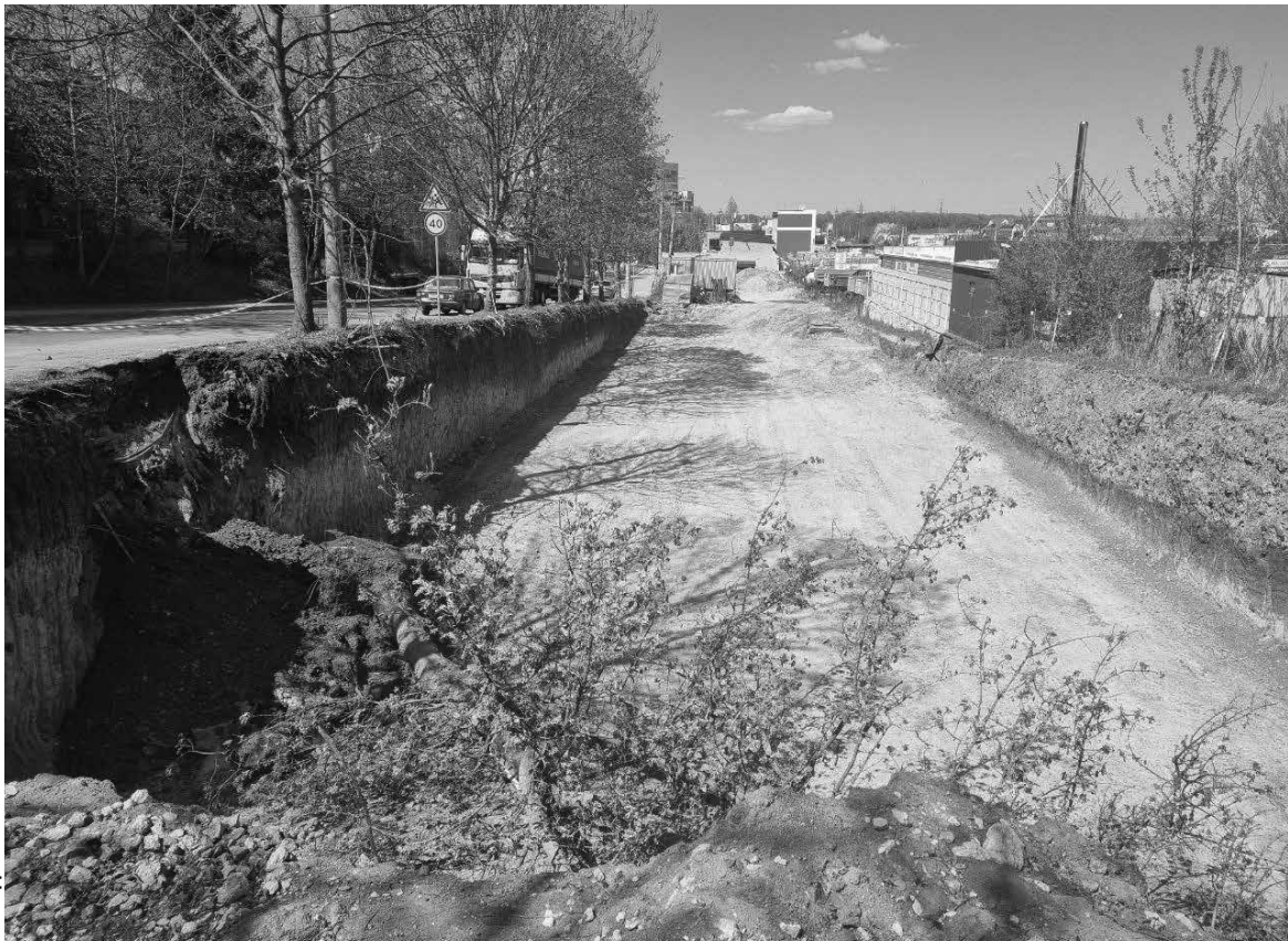
На ділянці розрівняли ґрунт. Поруч розташована парковка та автомийка. Одне з дерев, яке росло на узбіччі, впало до котловану
