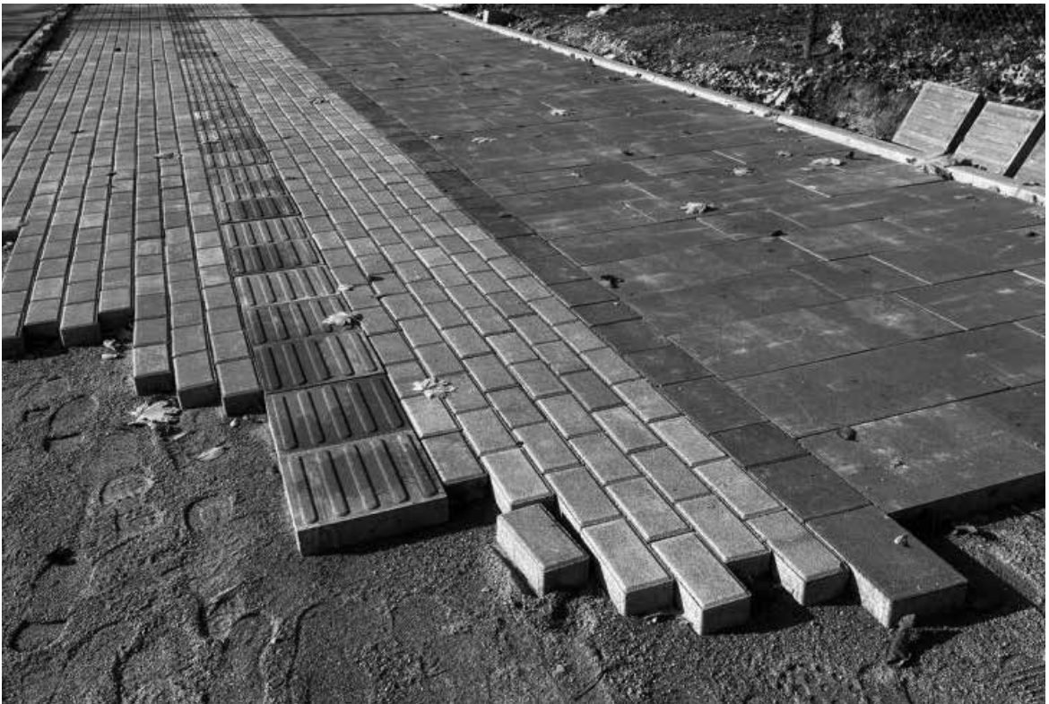
Договори на ремонт пішохідних доріжок уклали з виконавцем робіт
