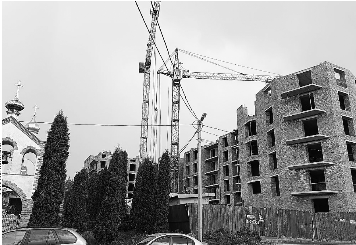
Триває зведення багатоповерхівки на вулиці Слівенська-Малишка. Паралельно тривають суди, де оскаржують законність такого будівництва
