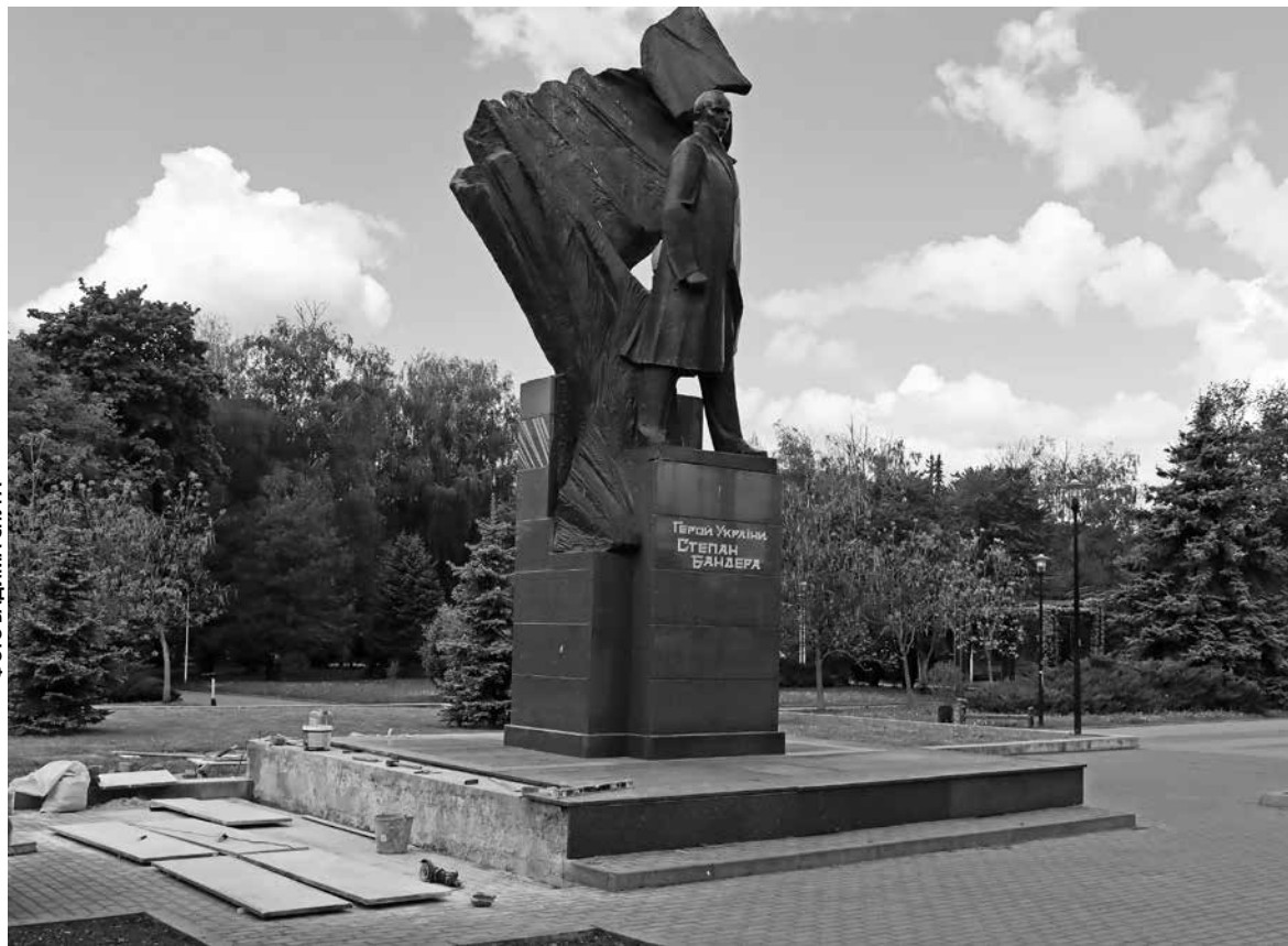
Гранітні плити залишаються старі. Робітники проводять демонтаж плит з постаменту. Роботи можуть зайняти до двох тижнів
