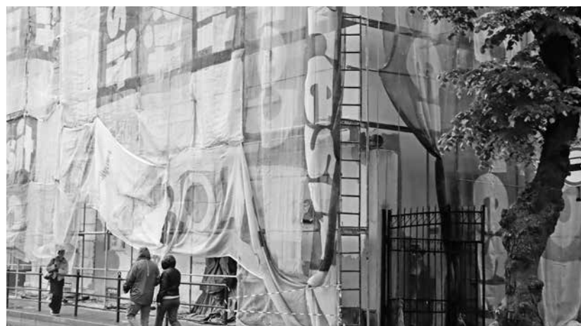
Перехожі обходять місце робіт
