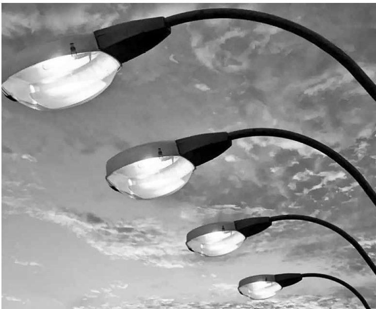
Замінити старі натрієві світильники зовнішнього освітлення на нові світлодіодні планують в обласному центрі. Це вартуватиме близько 26 мільйонів гривень
