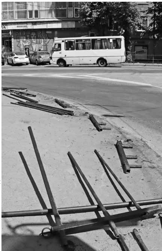
Зрізали опори вздовж дороги
