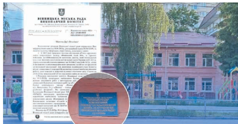
Ліцей №8 у Вінниці досі не відремонтували. Він постраждав внаслідок ракетного обстрілу 14 липня 2022 року
