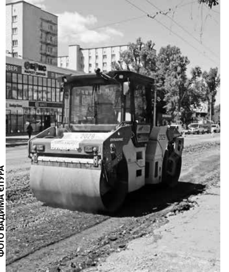
На вулиці працює спецтехніка
