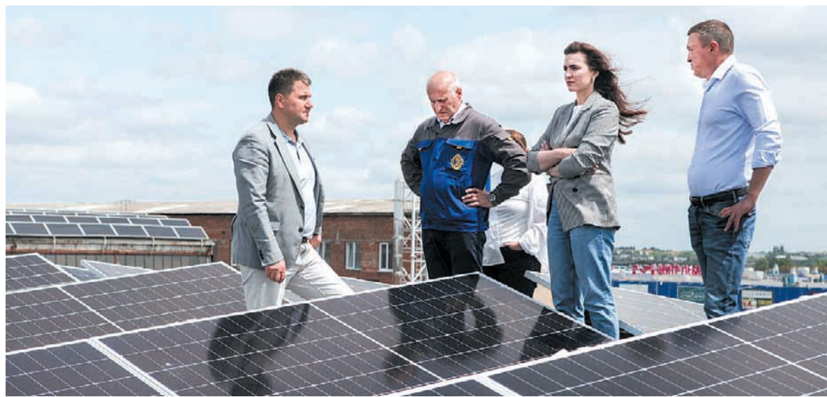
Нещодавно «Вінницький агрегатний завод» встановив сонячну електростанцію. На їхньому даху розміщені десятки фотомодулів, які мають 358 кВт потужності загалом
