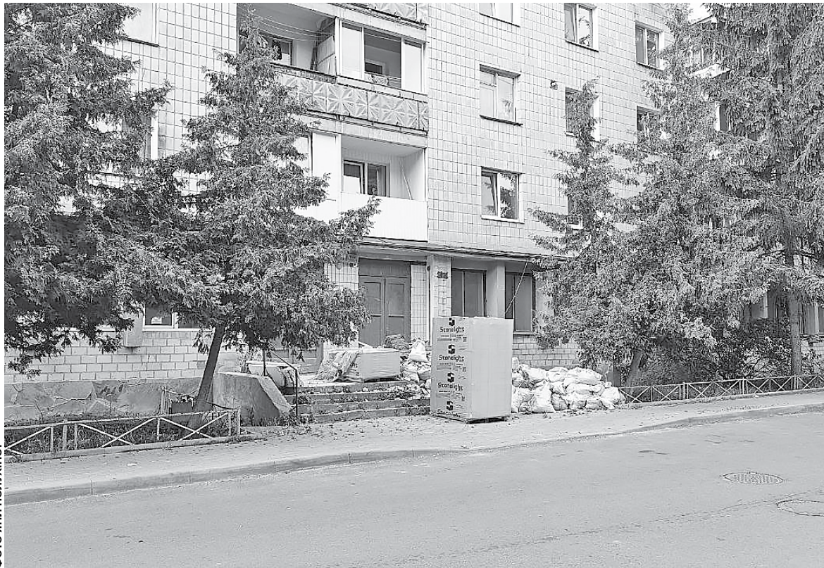
На капітальний ремонт нежитлових приміщень на вулиці Гузара, 1 передбачили майже 10 мільйонів гривень
