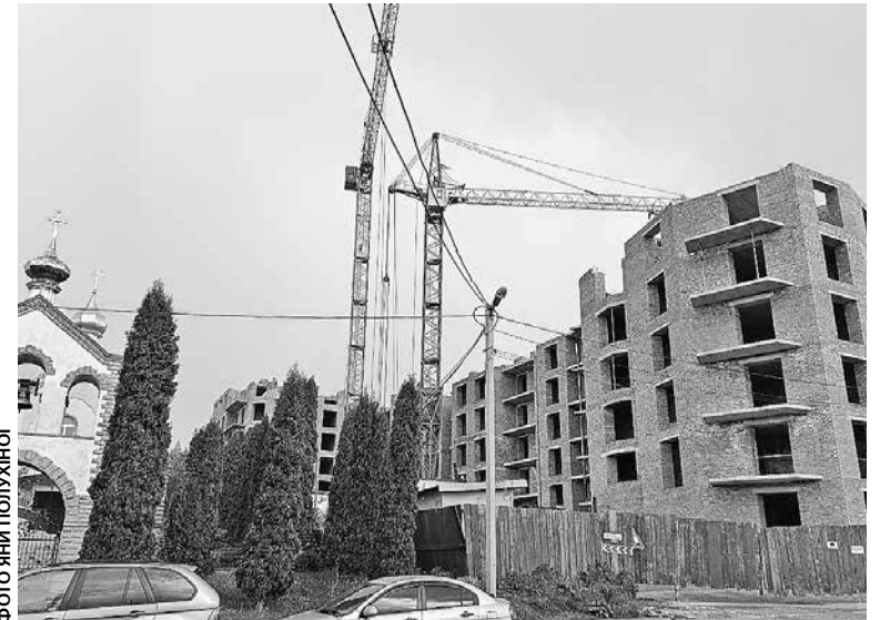
Замість Хресної дороги багатоповерхівку будують на вулиці Малишка-Слівенська. З 2022 року через це тривають суди
