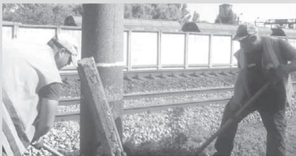
На вулиці Винниченка розпочали роботи з водовідведення. В самій нижній точці дороги спеціалісти з водовідведення зробили канал і відкачують з траншеї ґрунтові води.
