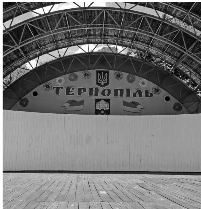
Покриття потребує заміни
