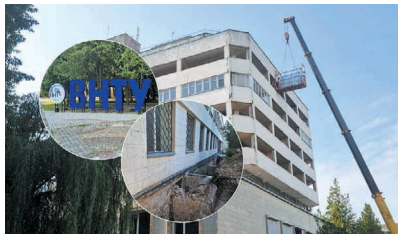
Будівельна техніка уже працює на території головного корпусу Вінницького політеху. У навчальному закладі нарешті проведуть термомодернізацію
