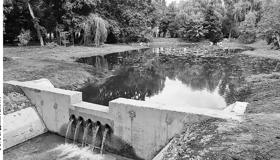
Завдяки новій підпірній стіні глибина водойми збільшиться
