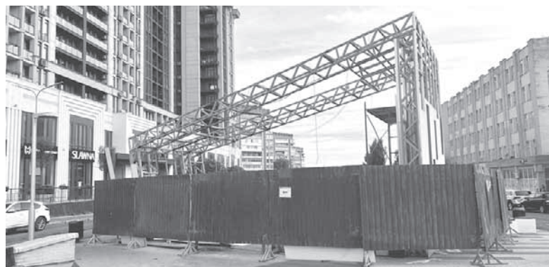
На Космонавтів ремонтують арку. Її стан був небезпечний для вінничан
