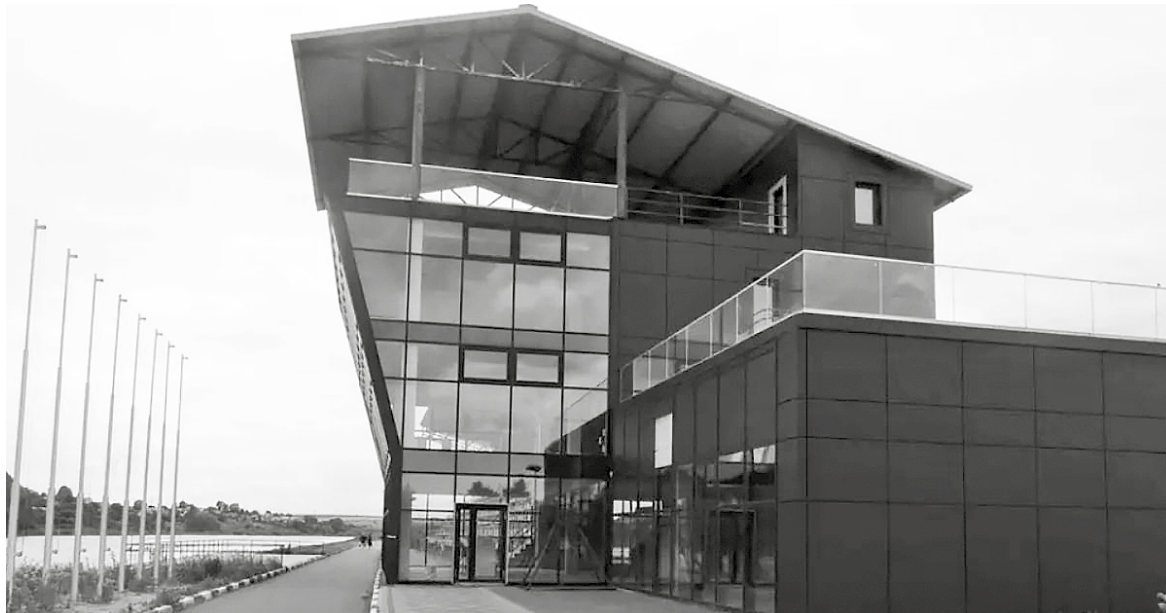
Майже рік триває слідство у справі про будівництво «Водної арени «Тернопіль». Перевіряють, як освоїли 96 мільйонів
