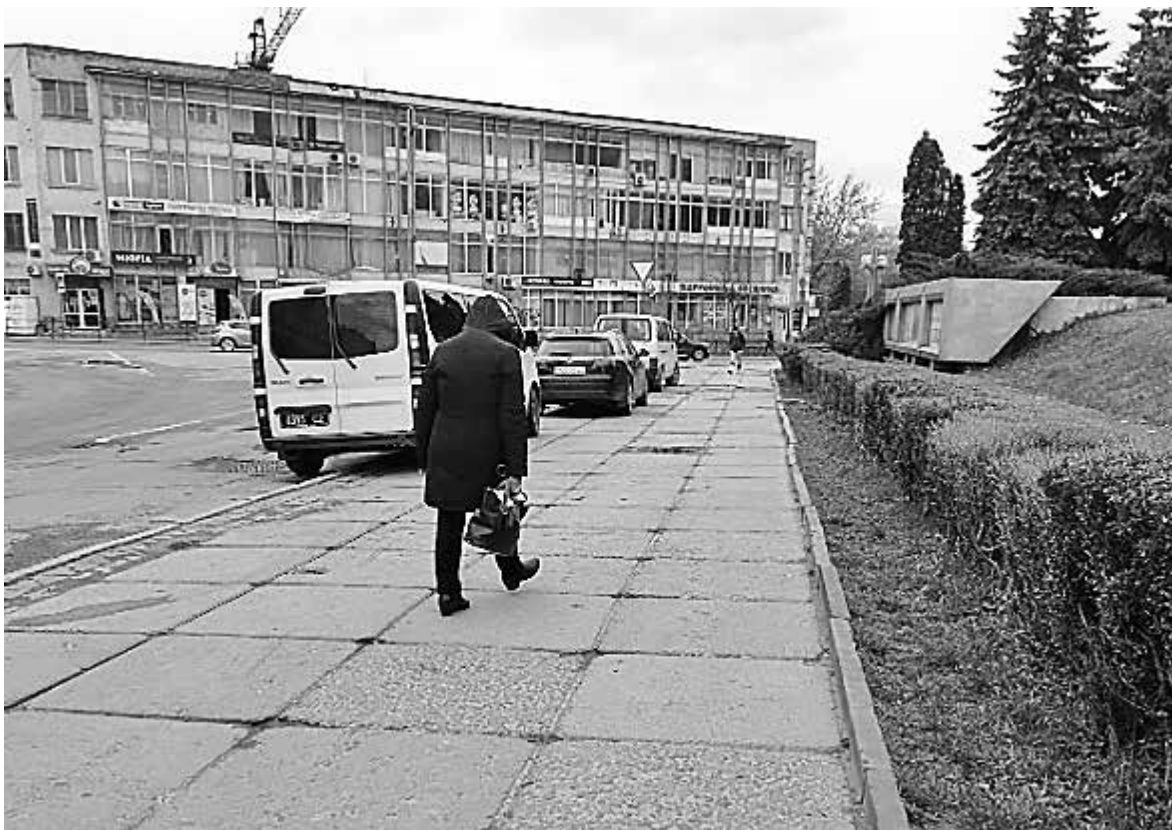
Таким був тротуар до реконструкції
