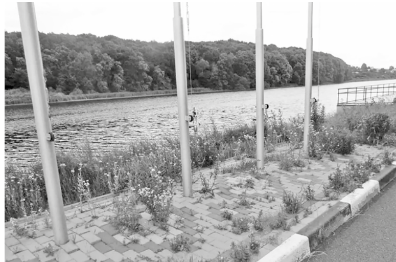
Ще у 2024 році «Водна арена» заростала травою, а стіни у деяких будівлях мали великі тріщини
