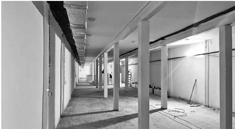
Додаткове укриття вирішили облаштувати у приміщенні тиру
