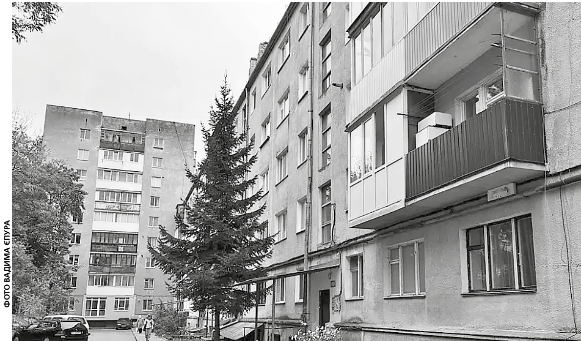
Технологічний запуск котельні триває щонайменше 72 години
