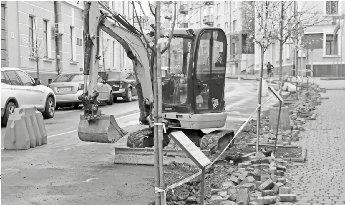
Почали демонтаж бордюрів та старої бруківки на тротуарі
