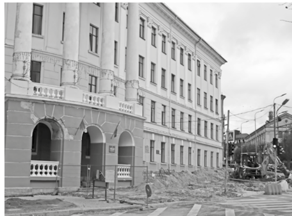
Біля школи №4 тривають роботи з реконструкції
