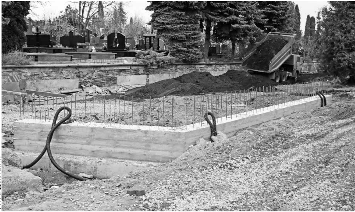
На вході до кладовища облаштували бетонний фундамент
