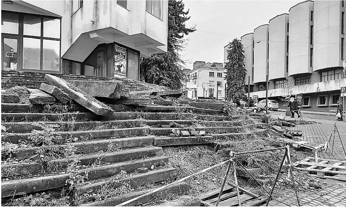
На площі Героїв Євромайдану почали роботи біля будівлі закинутого торговельного центру Grand
