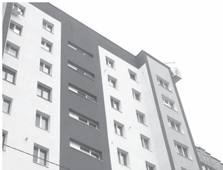
Термомодернізацію почали ще влітку. Цей дім тепер має утеплений фасад та замінені віконні блоки у під'їздах
