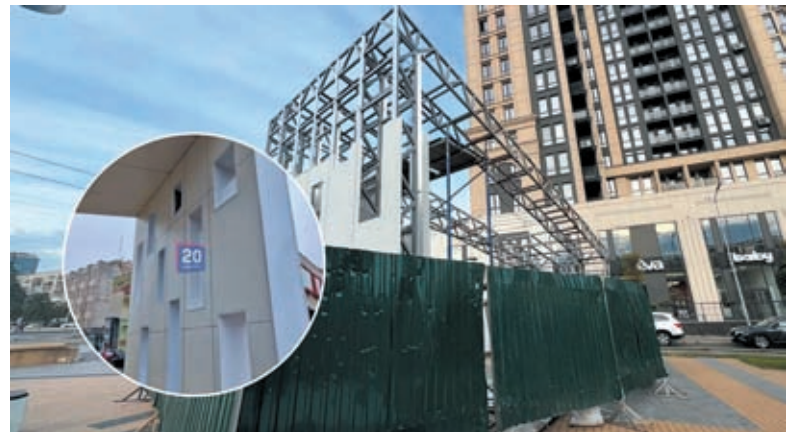
На проспекті Космонавтів закінчили ремонт арки. Її вигляд зберегли, але відновили підсвітку
