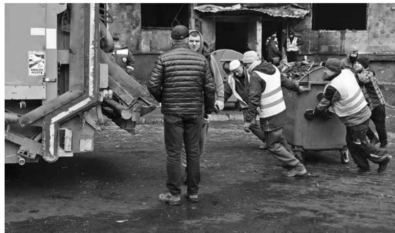
Комунальники вивезли близько 1298 тонн будівельного сміття
