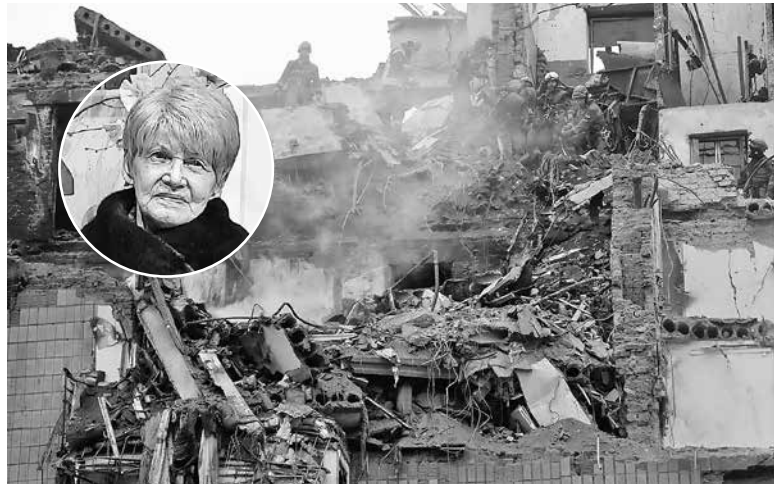
Ось такий вигляд мала квартира 85-річної тернополянки після обстрілу — суцільні руїни
