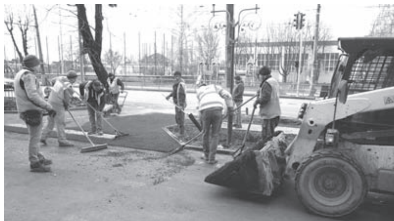
Ремонт на вулиці Київській набирає темпу. Дорожники укладають новий асфальт, встановлюють понижені бордюри
