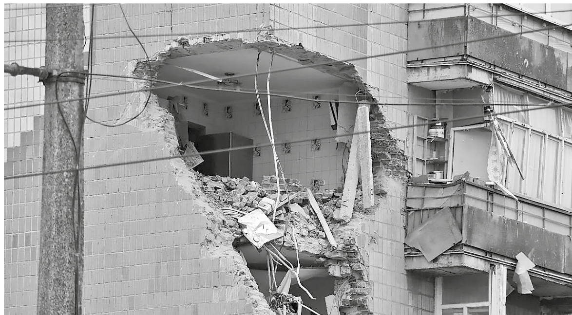
Будівлю руйнують поступово, щоб не сталося неконтрольованого обвалу
