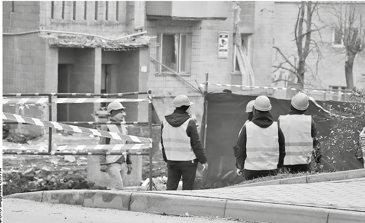
На місці 8 грудня працювала бригада робітників, які займаються демонтажем
