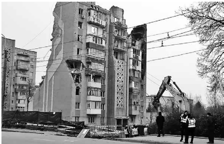
Демонтаж аварійного будинку на вулиці Василя Стуса тривав менше тижня
