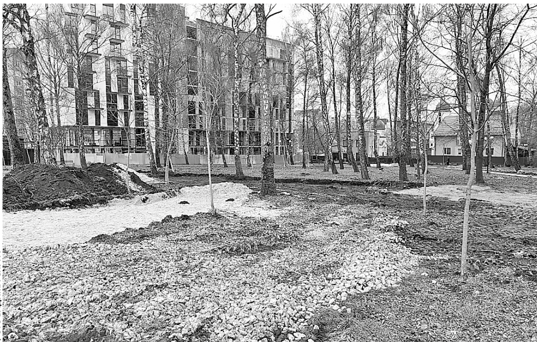
Територію підготували для будівництва нового майданчика
