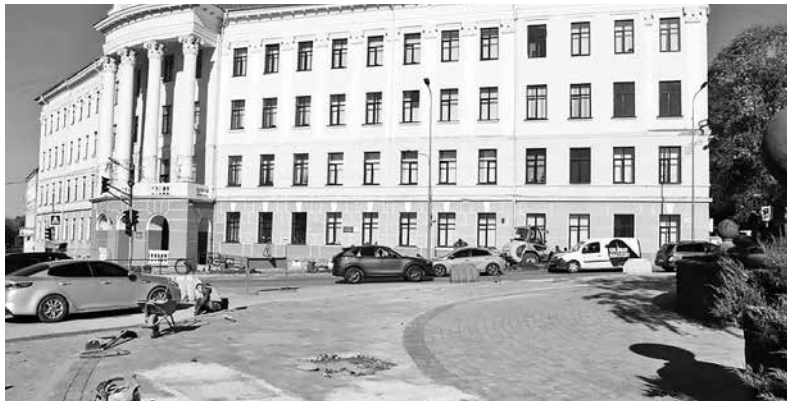
Майже 10 мільйонів не вистачило на ремонт Грушевського. Управління ЖКГ уклало ще один договір на додаткові роботи
