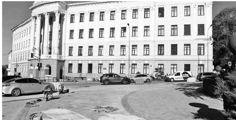
Майже 10 мільйонів не вистачило на ремонт Грушевського. Управління ЖКГ уклало ще один договір на додаткові роботи
