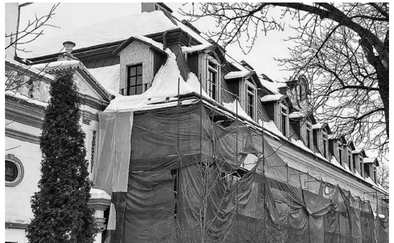
Частково навколо будівлі є металеве риштування та захисна сітка
