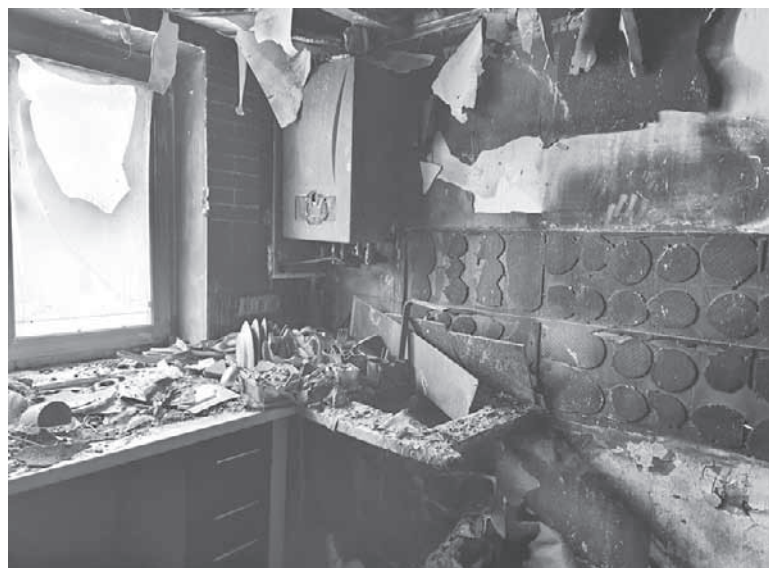
Найбільше вогонь пошкодив кухню. У холодильника, точніше того, що від нього залишилося, вигнулися дверцята. Зі стін відпала плитка, знищені меблі, стеля та вікно
