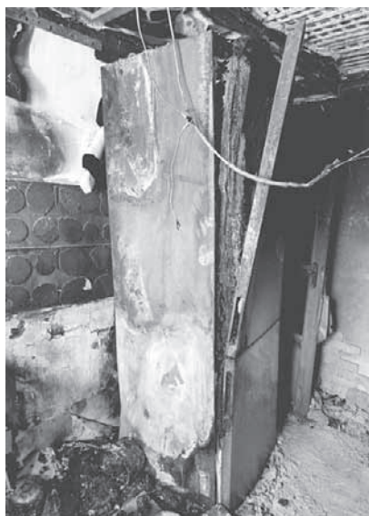
Найбільше вогонь пошкодив кухню. У холодильника, точніше того, що від нього залишилося, вигнулися дверцята. Зі стін відпала плитка, знищені меблі, стеля та вікно
