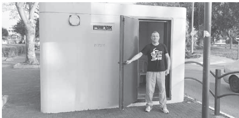
Сергій Мар'янчук показує мобільний пересувний модуль. Такі споруди виготовляють з бетону підвищеної якості, встановлюють у людних місцях
