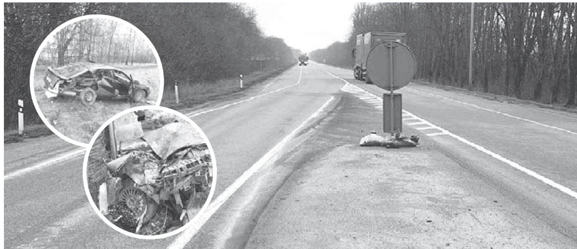
Бетонні «острівці безпеки» на трасі М-30, які мали захищати водіїв, насправді часто стають причиною аварій. Кожен такий об'єкт може обернутися трагедією
