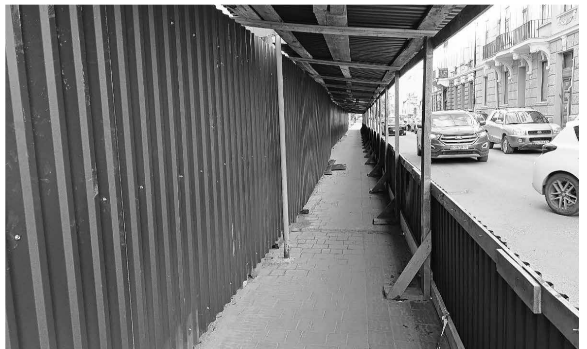
Для безпеки перехожих біля будівлі на Франка, 3 зробили критий прохід тротуаром
