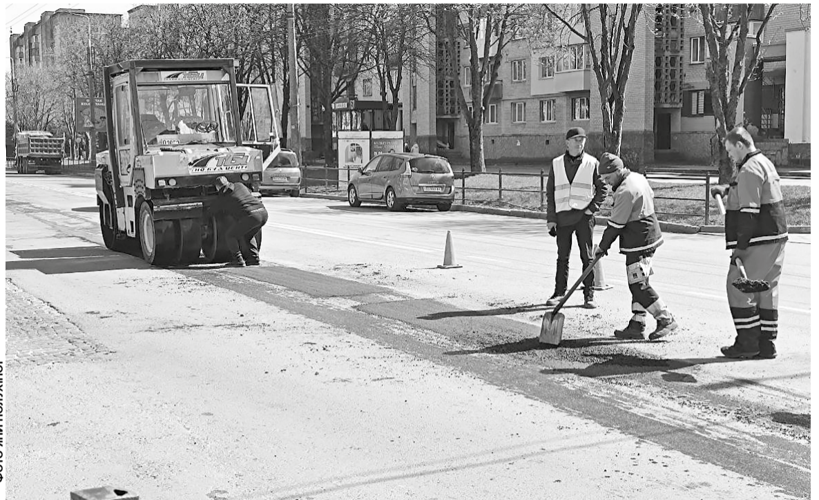
На дорогах Тернополя проводять поточні, а також ямкові ремонти
