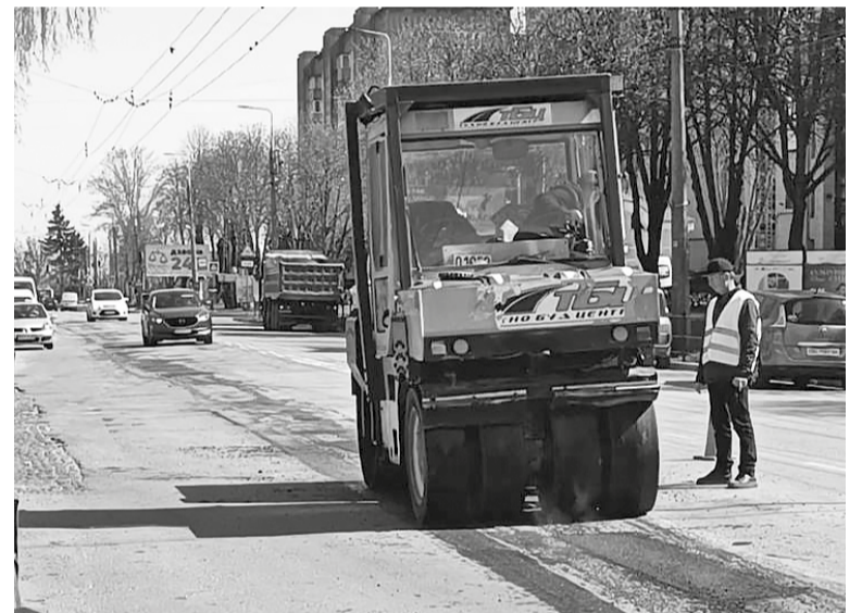
Ремонт доріг має виконувати ТОВ «Техно-Буд-Центр», що стало переможцем тендера
