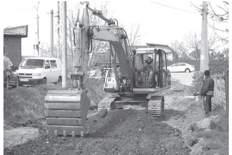
Це капремонт вулиці, де працівники спочатку вирівнюють дорогу. Потім будуть підсипати щебінь та займуться асфальтуванням
