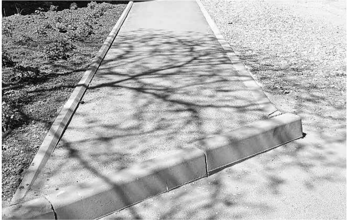
Після робіт водоканалу тротуар на Стуса, 2 відновили, але не передбачили понижень для доступності
