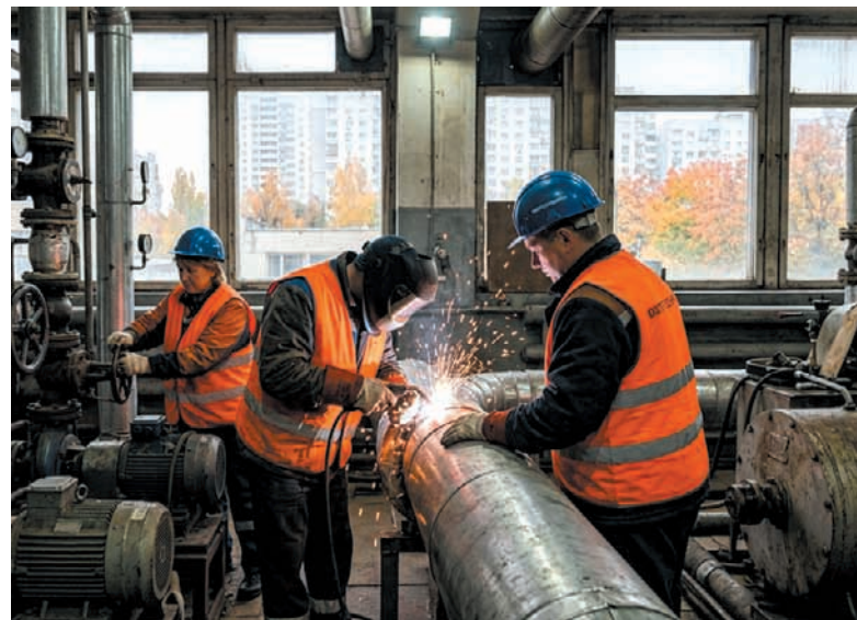
Вінниця готується до зими завчасно. Комунальники вже ремонтують теплові мережі — до початку опалювального сезону роботи мають завершити до 9 жовтня
