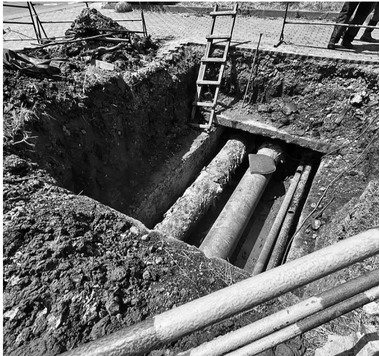
Гроші спрямують на заміну трубопроводів теплових мереж, запірної арматури та насосного обладнання
